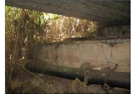
VUE AMONT (DROITE)
